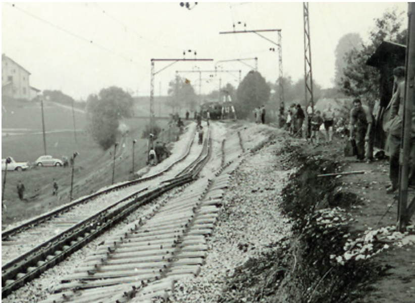
Der Unterbruch der Bahnlinie im Jahr 1958. Die Rutschung hatte zur Folge, dass die SBB die angrenzenden Grundstücke erwarb und die Lehmgrube des Ziegelwerkes mit Wasser füllte. Deshalb befinden sich dort heute die Ziegeleiweiher.
