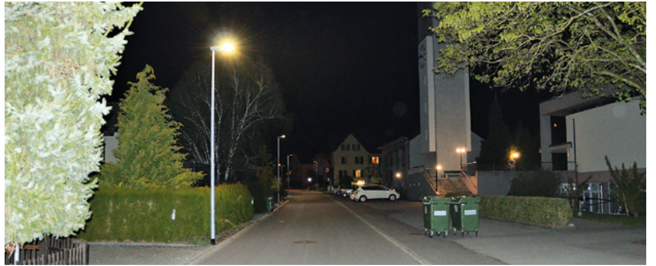
Die Wiesenstrasse wird mit LED-Lampen beleuchtet.
