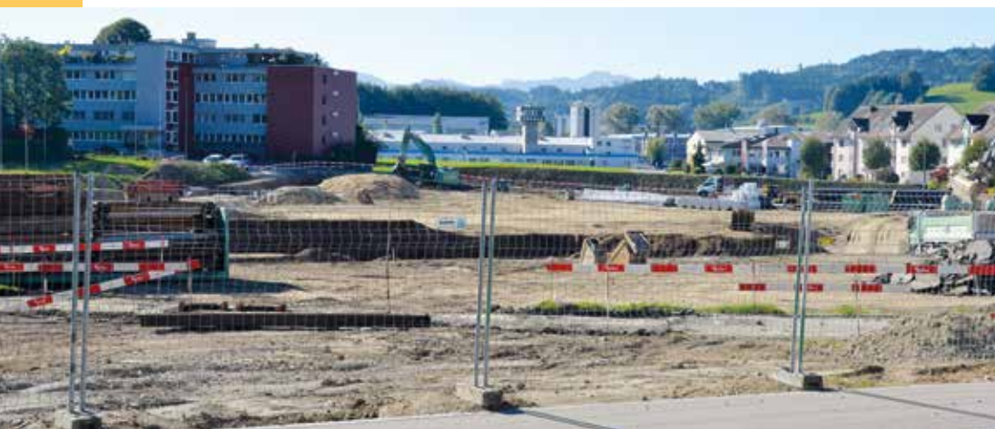
Die Erschliessung des Gebietes Lindenacker läuft auf Hochtouren.
