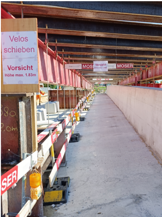
Sanierung und Verbreiterung der Hörnlibrücke
