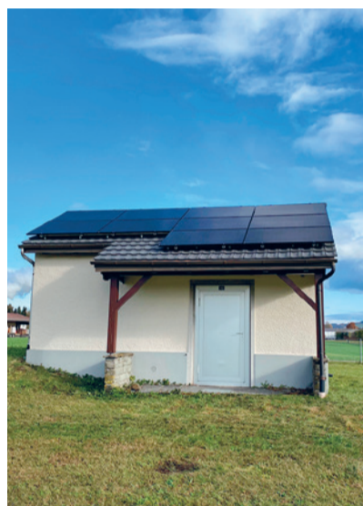
Pumpwerk Ämtwis, Büfelden
