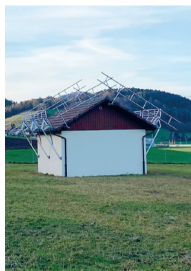
Pumpwerk Zisterwis, Wallenwil
