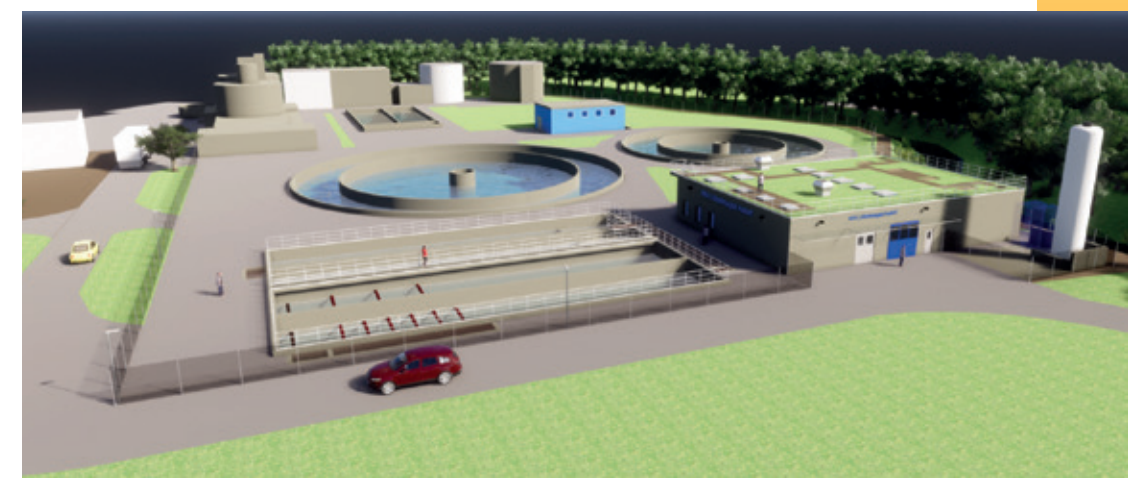
Der Erweiterungsbau der ARA Aadorf hat Auswirkungen auf die Kanalisationsgebühren.
